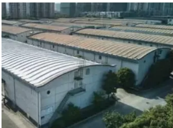
Entrepôt de stockage après traitement de toiture.
